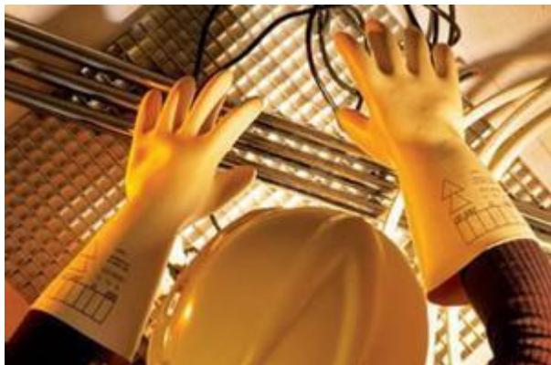
Безопасность работ, проводящихся на электрических установках, обеспечивают благодаря несколькими группам средств защиты. Что относится к электрозащитным средствам:
